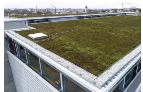
Das Wasserrückhaltevermögen beträgt 20 l/m 2 .
