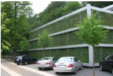
Jedes Pflanzgefäß wird mittels des Bewässerungssystems mit Nährstoffen und Wasser versorgt.
