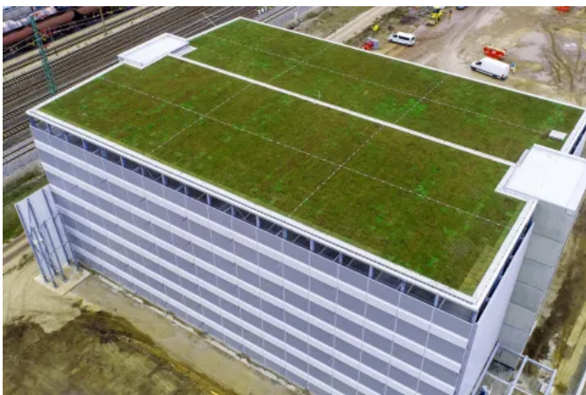
Die Kassetten des Systems bestehen aus recyceltem, schadstofffreiem und wiederverwertbarem Polypropylen (PP).
