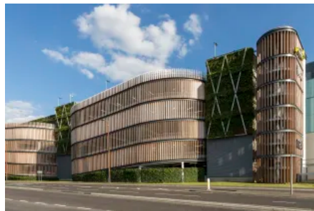
Damit ein Wasserüberschuss im Pflanzkübel vermieden wird, verfügt jeder Kübel auch über eine Drainage.
