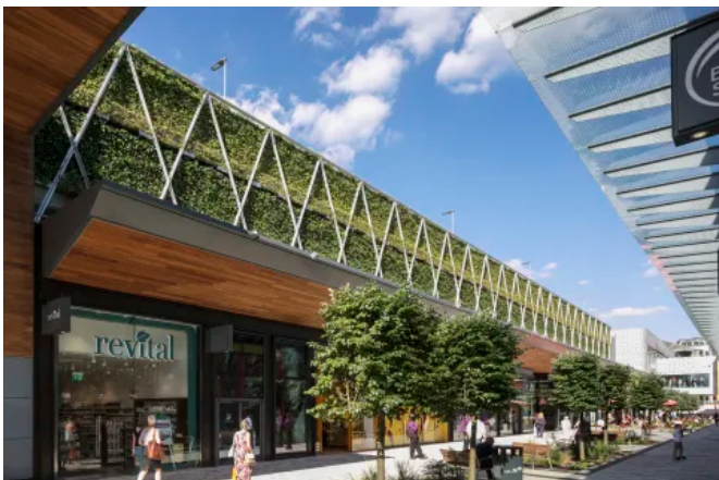
WallPlanter stellt eine Kombination aus Fertighecken und einem nachhaltigen System für grüne Fassaden dar.
