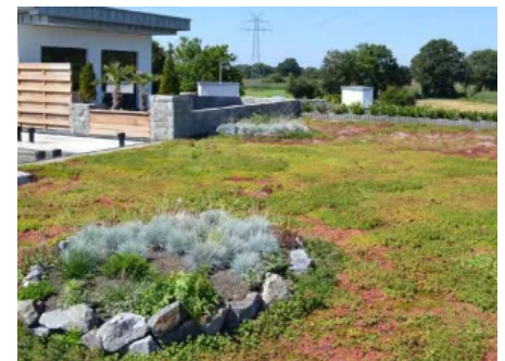
Dachdeckung mit TOPGREEN Gründachschale GDS 15 (© TOPGREEN)
