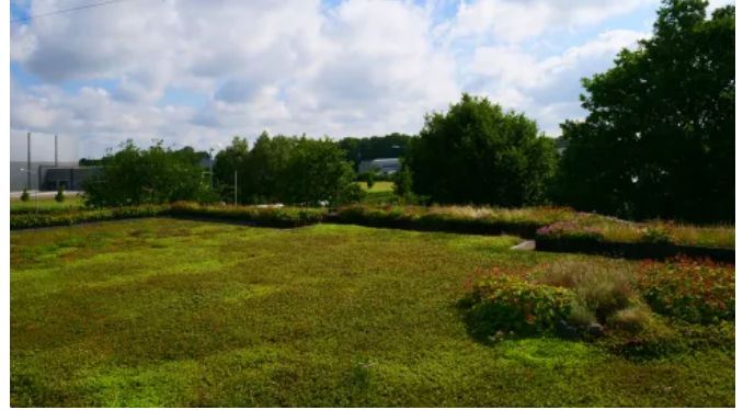
Dachdeckung mit TOPGREEN Gründachschale GDS 15 (© TOPGREEN)
