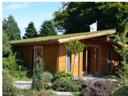
Dachdeckung mit TOPGREEN Gründachschale GDS 15 (© TOPGREEN)
