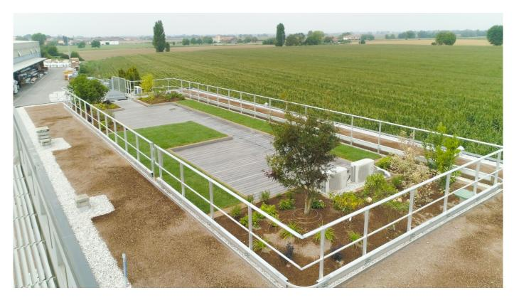
GreenROOF wird auf den Isodeck PVSteel-Paneelen installiert, die als Basis für Flachdächer verwendet werden. Das Außenblech ist mit einer schützenden, wurzelund wasserfesten Kunststofffolie aus PVC (mit FLL-Zertifizierung) oder FPO (flexible plastische Elastomere auf Olefinbasis) beschichtet. Die Wärmeisolierung wird durch den Kern aus Polyurethanschaum oder Steinwolle gewährleistet.
