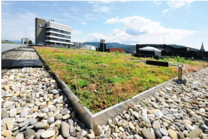
Substratschienen fassen die Sedum-Matten ein und trennen die Begrünung von der umliegenden Kiesschüttung.
