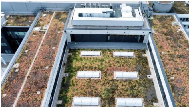
Klimaverbesserer mitten in Berlin: Das weitläufige Retentions-Gründach der Stadler Deutschland GmbH.
