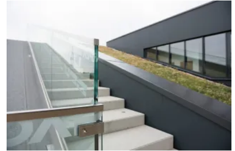
Dachbegrünung auf geneigter Dachfläche
