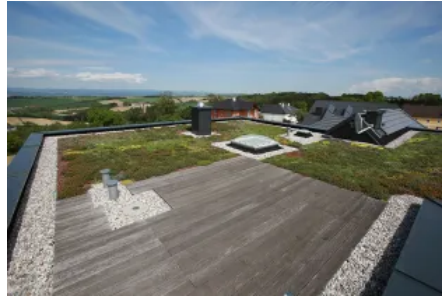
Flachdachbegrünung mit Terrassendeck
