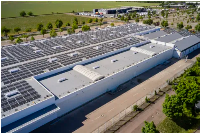
Druckereigebäude, Zeithain | Verwendetes Produkt: Rhepanol hfk | © Lars Behrendt
