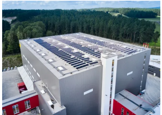
Warenverteilzentrum Witt, Weiden | Verwendetes Produkt: Rhenofol CV
