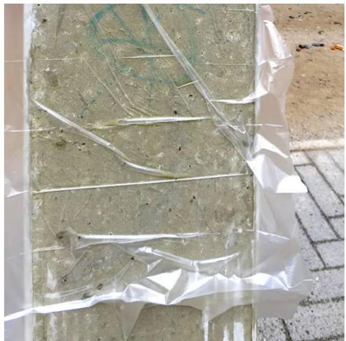
Oxydizer Gel bleicht Tinten und Pigmentreste auf alkalisch beständigen Untergründen.
