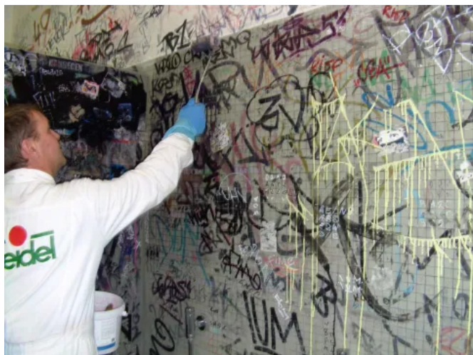
Auftragen des Graffiti-entferners mit der Farbwalze.
