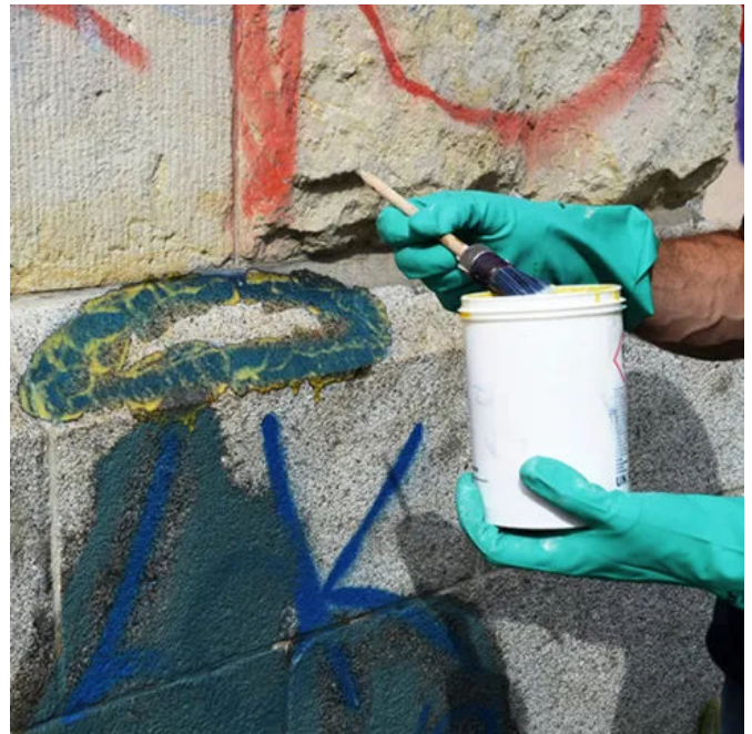
Cracker Gel zur Graffiti-entfernung auf alkalisch beständigen Untergründen
