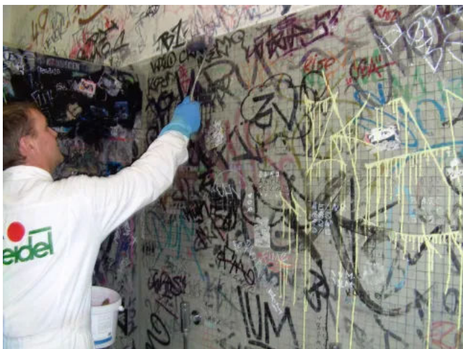
Auftragen des Graffiti-entferners mit der Farbwalze.
