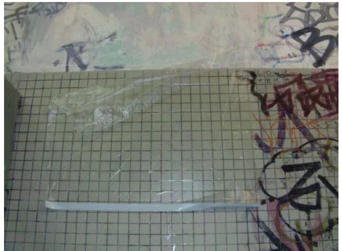
Die meisten Schatten von den Stiften wurden mit Scheidel Oxydizer GEL mit einer Einwirkzeit von ca. 18 h unter Folie weggebleicht.
