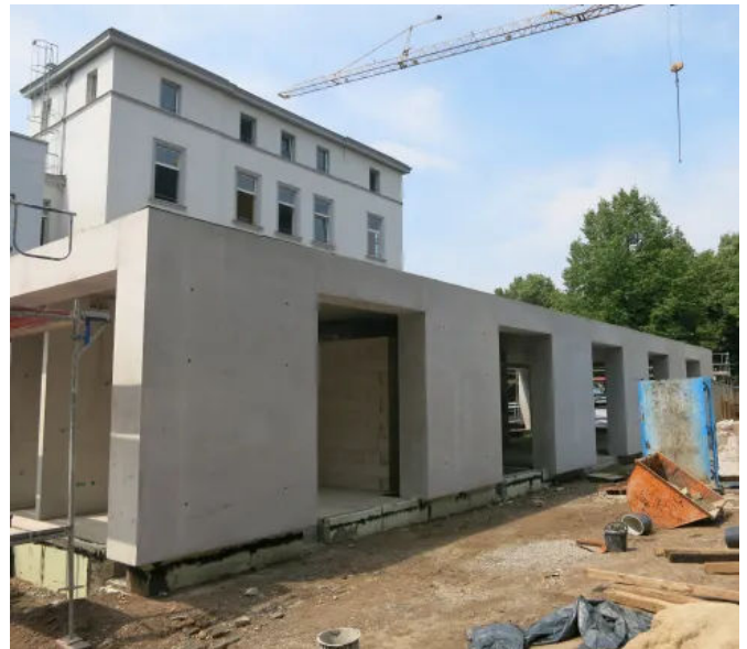
Kirchenpavillon in Bonn in der Bauphase
