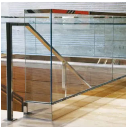
Brüstungsverglasung mit Sonderoberfläche in Glanzchrom.
