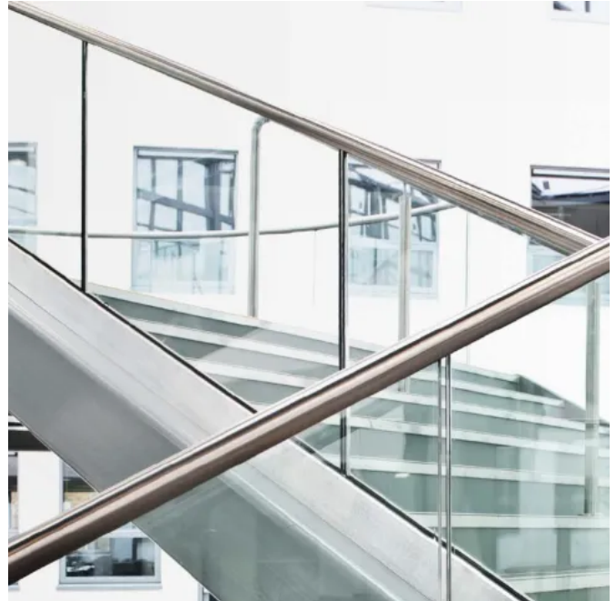
Treppengeländer-Verglasung mit Handlauf aus Edelstahl
