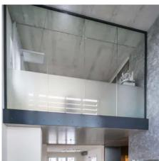
Galeriebüro: Absturzsicherung mit maßgefertigter Stahlkonstruktion.
