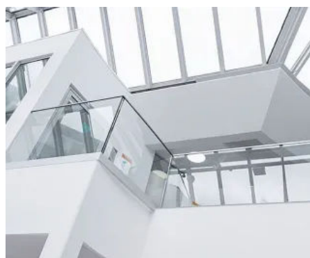
Anwendungsbeispiel Ganzglasbrüstung mit Edelstahl-Kantenschutzprofil
