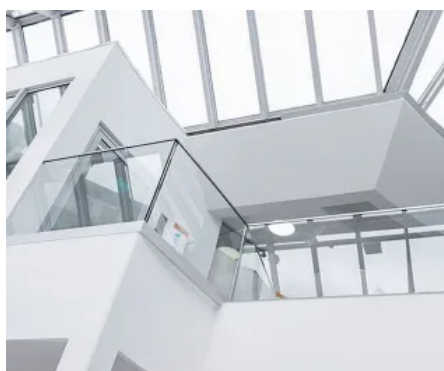
Anwendungsbeispiel Ganzglasbrüstung mit Edelstahl-Kantenschutzprofil
