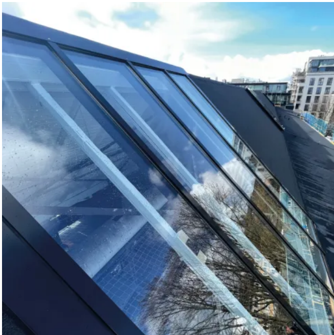
Die vorhandenen Glasdachkonstruktionen wurden technisch und gestalterisch erneuert.
