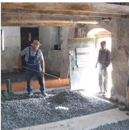
GLAPOR Schaumglasschotter als Bodendämmung
