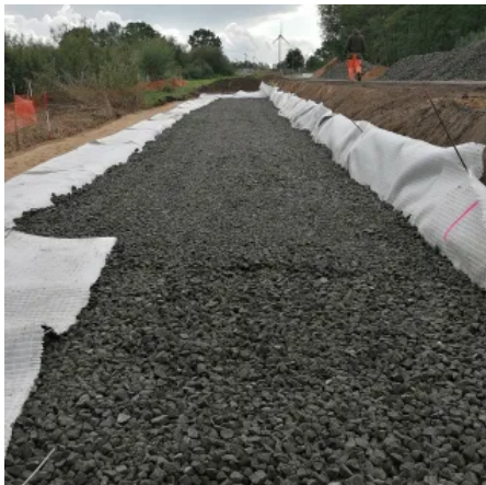
GLAPOR Schaumglasschotter als Verkehrswegauffüllung
