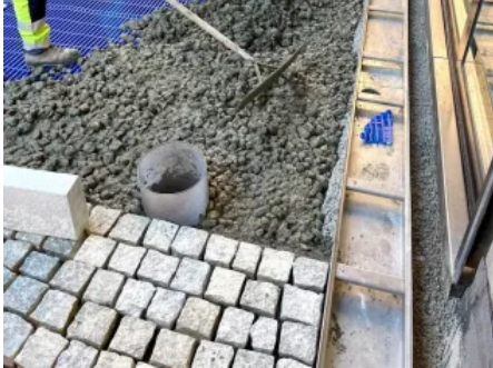
GLAPOR Schaumglasschotter als gebundene Schüttung
