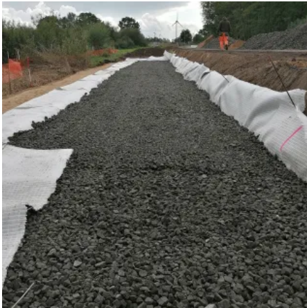
GLAPOR Schaumglasschotter als Verkehrswegauffüllung
