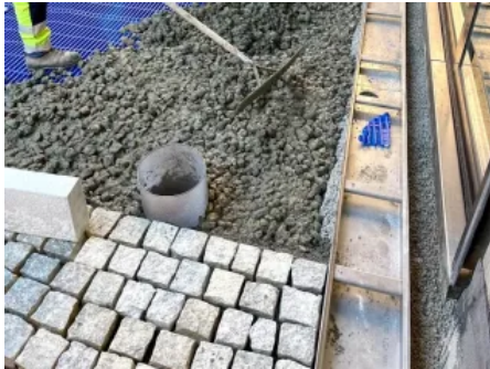
GLAPOR Schaumglasschotter als gebundene Schüttung
