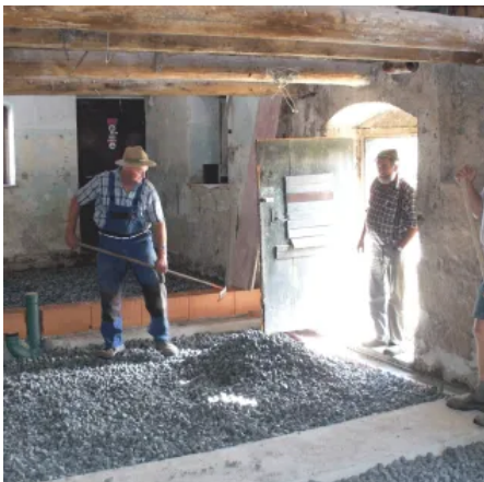
GLAPOR Schaumglasschotter als Bodendämmung
