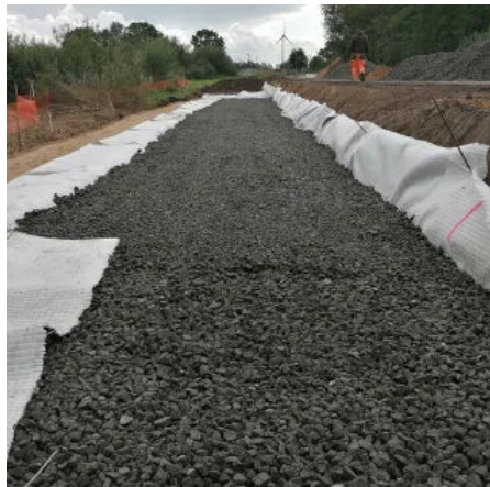
GLAPOR Schaumglasschotter als Verkehrswegeauffüllung
