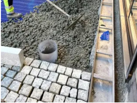
GLAPOR Schaumglasschotter als gebundene Schüttung
