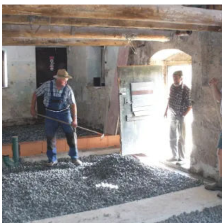
GLAPOR Schaumglasschotter als Bodendämmung
