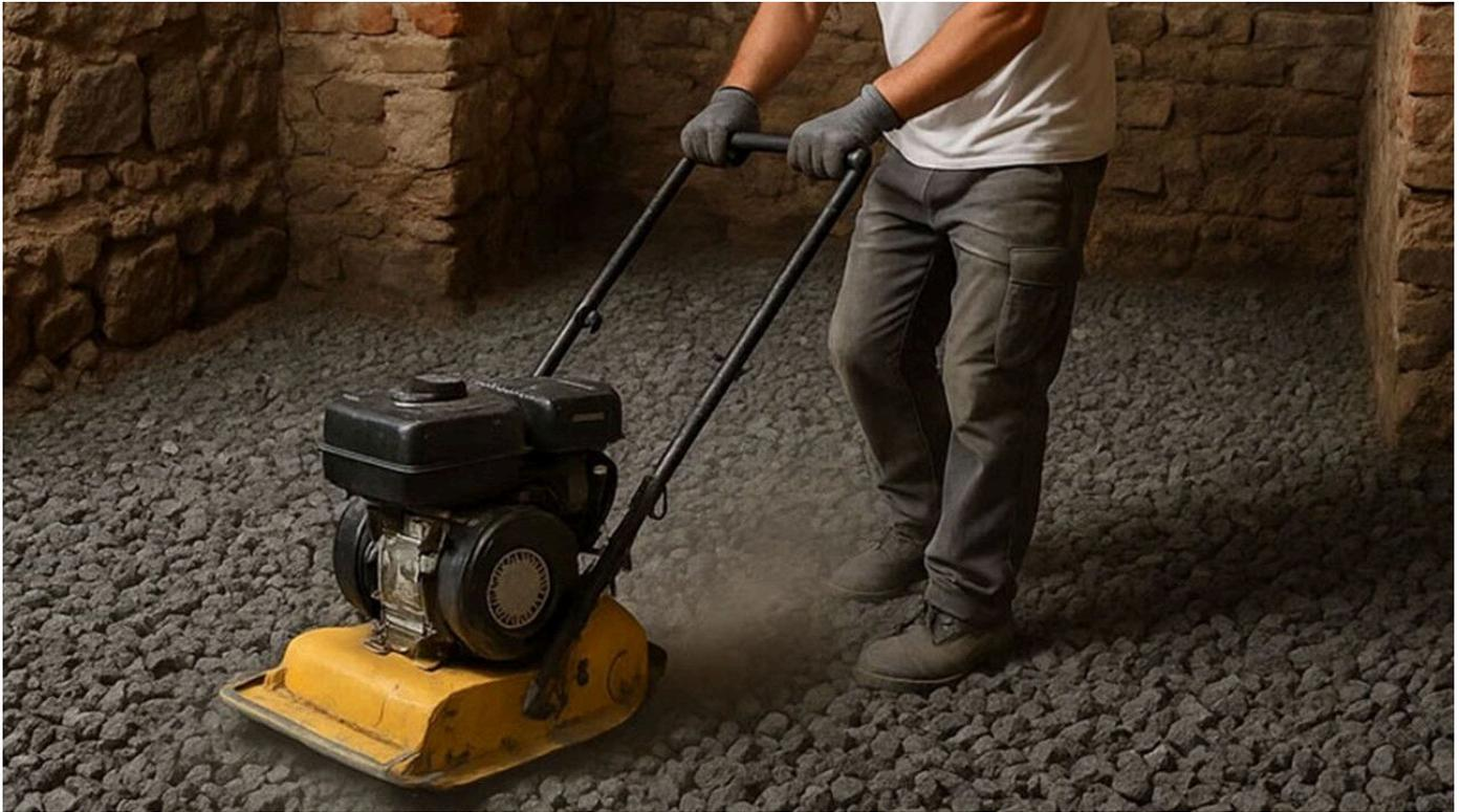
GLAPOR Schaumglasschotter bietet sehr gute lastabtragende Eigenschaften mit einer Nenndruckfestigkeit von bis zu 800 kPa. In Kombination mit den GLAPOR RDS Elementen als Kopf- und Randdämmschalung (die Lastabtragung darf hier nicht am RDS Element angesetzt werden) ergibt sich ein kunststofffreies Kombi-Perimeterdämmsystem für nachhaltige Bauweisen.
