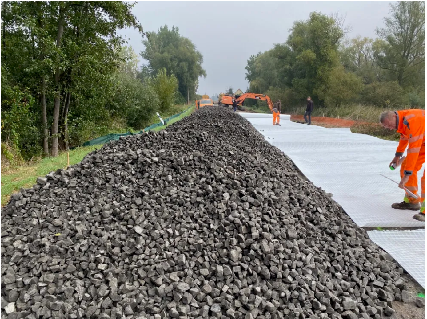
GLAPOR Schaumglasschotter als Verkehrswegeauffüllung
