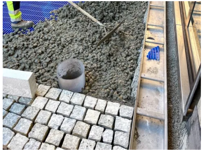
GLAPOR Schaumglasschotter als gebundene Schüttung
