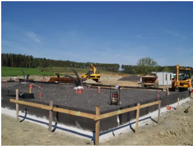
GLAPOR Schaumglasschotter als Perimeterdämmung mit RDS Schalungselementen
