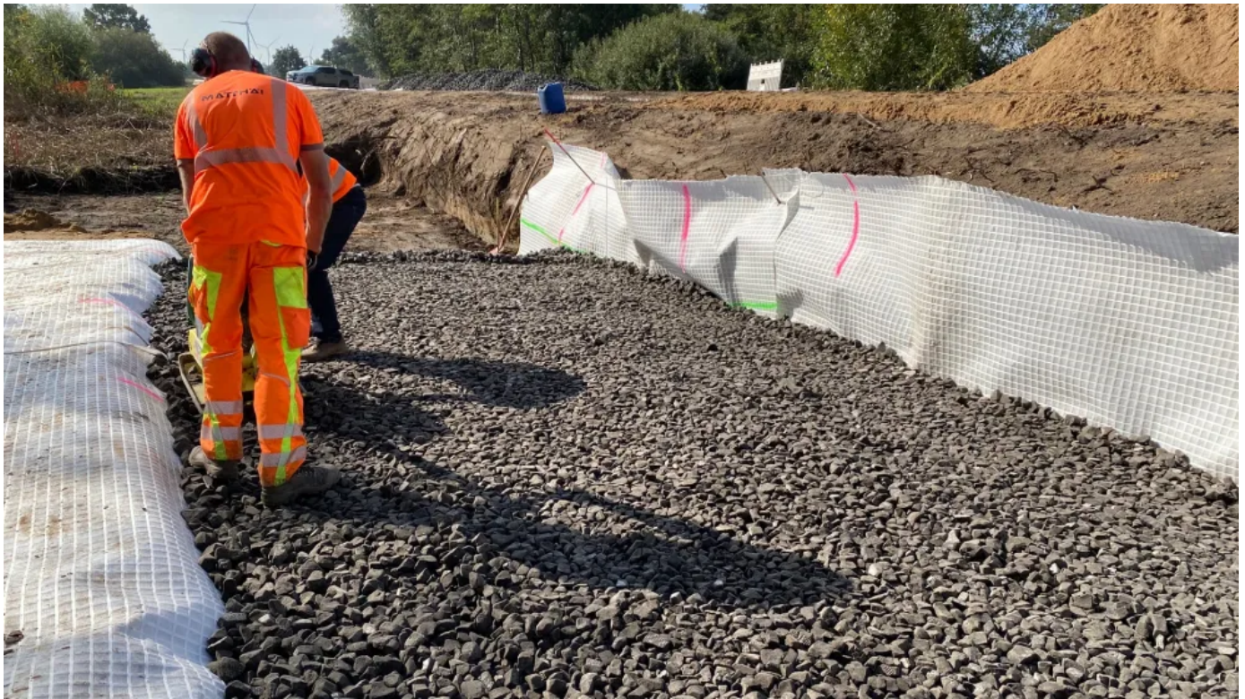
Glapor SG 800 Verkehrswegauffüllung, Brandenburg
