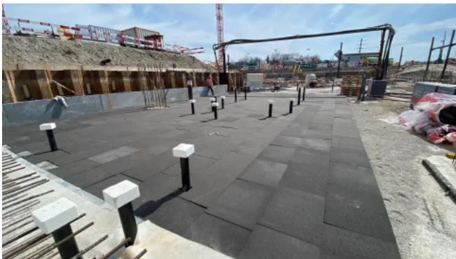
GLAPOR Wärmedämmung aus Schaumglasplatten
