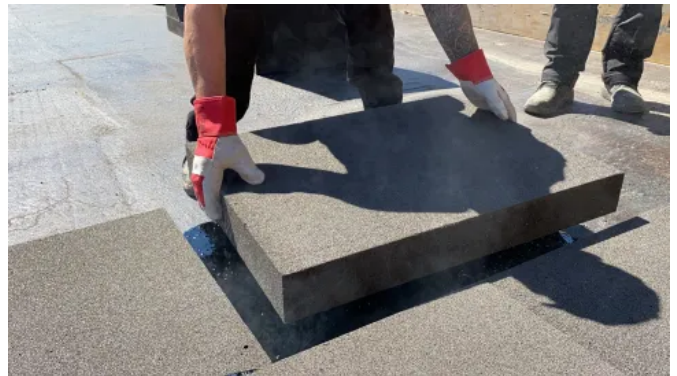
GLAPOR Wärmedämmung aus Schaumglasplatten
