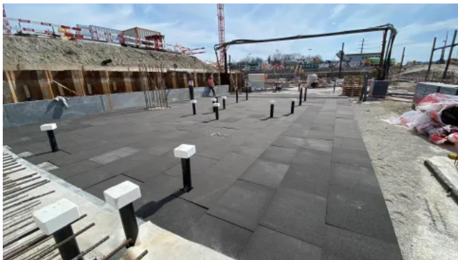
GLAPOR Wärmedämmung aus Schaumglasplatten
