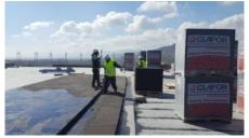
GLAPOR Wärmedämmung aus Schaumglasplatten
