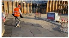
GLAPOR Wärmedämmung aus Schaumglasplatten
