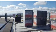
GLAPOR Wärmedämmung aus Schaumglasplatten
