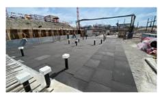
GLAPOR Wärmedämmung aus Schaumglasplatten
