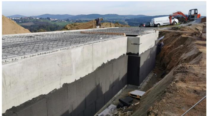
Kellerdämmung mit GLAPOR Schaumglasplatten
