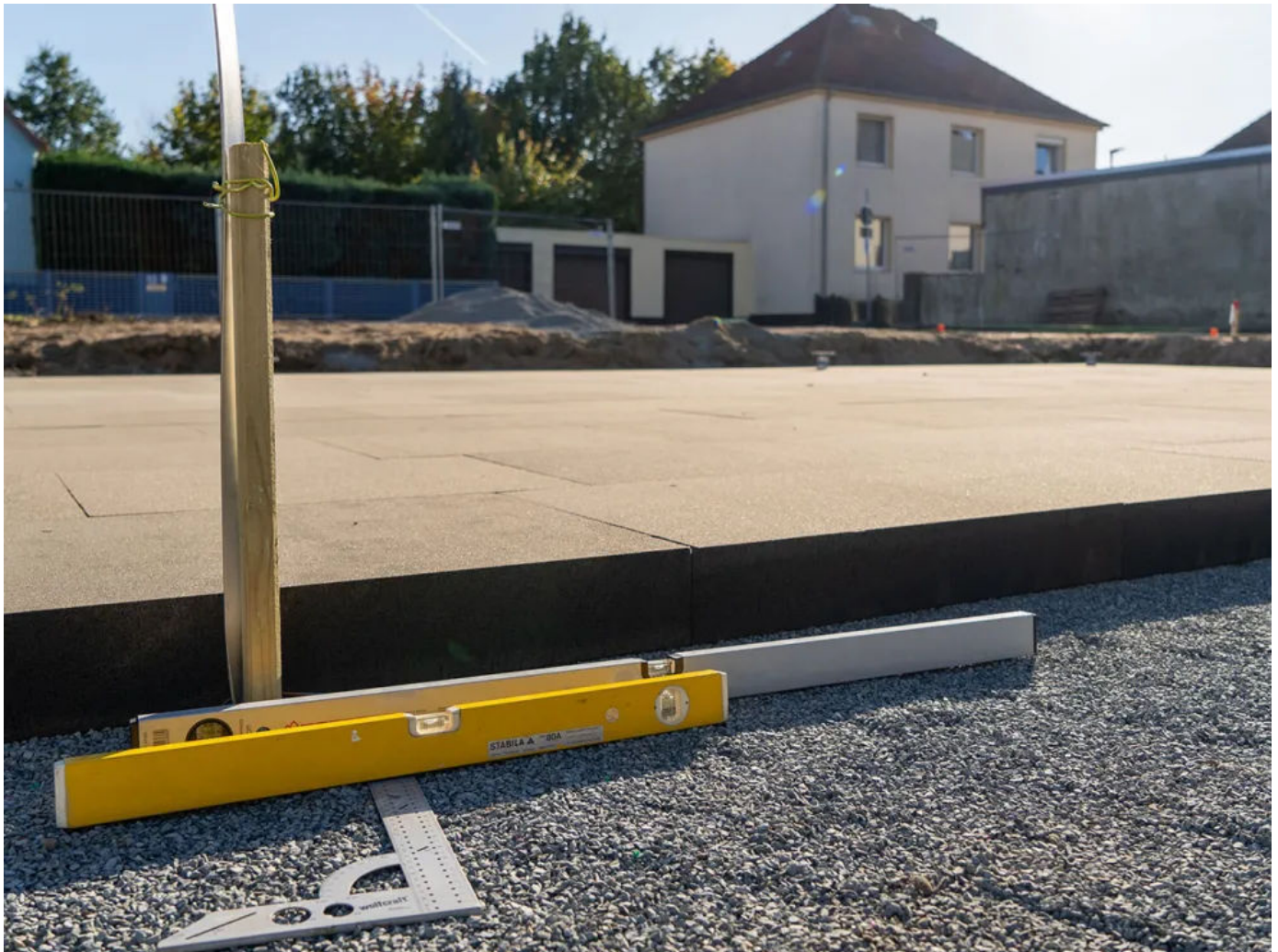
Die Verlegung der GLAPOR Schaumglasplatten erfolgt durch einfaches Auflegen im Splittbett im Versatz.
