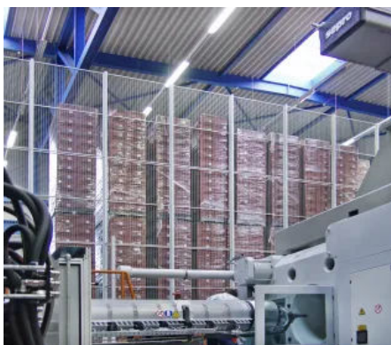
MultiSafe Gittertrennwände in einer Produktionshalle, Sonderhöhe
