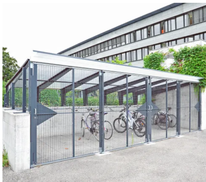
Gittereinhausung aus MultiSafe Gittertrennwänden mit Schiebetür
