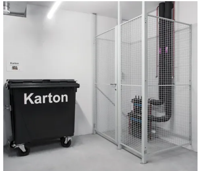
Technikabsicherung mit Gittertrennwand MultiSafe
