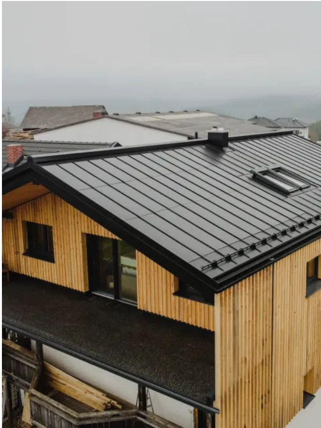
Land: Österreich, Ort: Salzburger Schieferalpen, Objekt: Alpine Berghütte; Installation: 2023; Leistung: 23,14kWp
