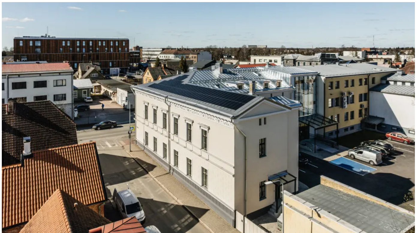
Land: Estland, Ort: Viljandi, Objekt: Kulturakademie; Installation: 2025; Leistung: 10,21 kWp
