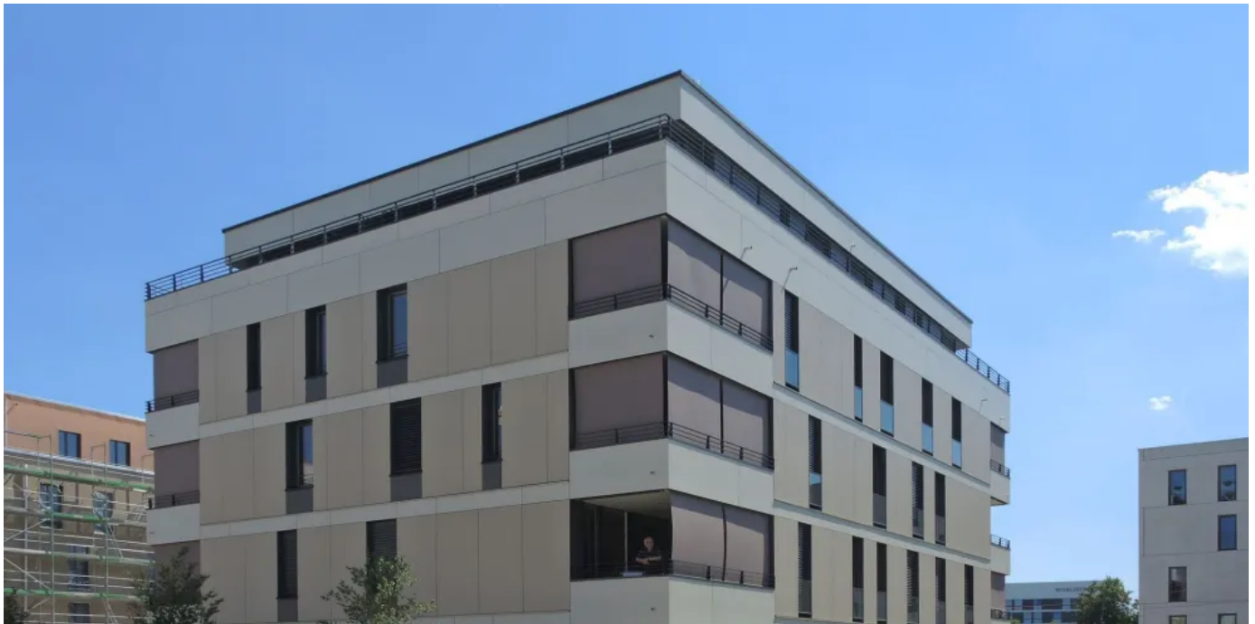
Mehrfamilienhaus Stadtquartier Domagkpark, München
