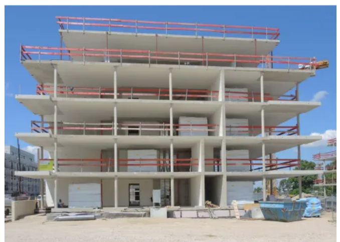
Hybridbau mit nichttragender Fassadenkonstruktion aus vorgefertigten Holzbauelementen
