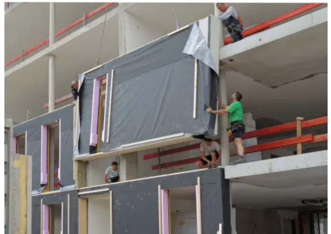
Hybridbau mit nichttragender Fassadenkonstruktion aus vorgefertigten Holzbauelementen
