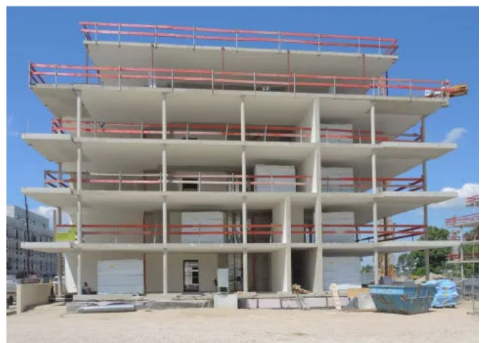
Hybridbau mit nichttragender Fassadenkonstruktion aus vorgefertigten Holzbauelementen
