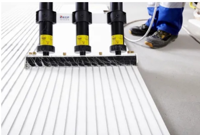
Maschineller Kleberauftrag (ca. 40 Sekunden pro m 2 )
