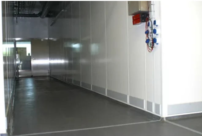
GFK-Dämmelemente mit H-Profil-Fuge
