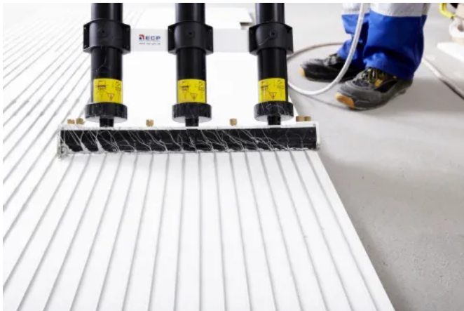
Maschineller Kleberauftrag (ca. 40 Sekunden pro m 2 )
