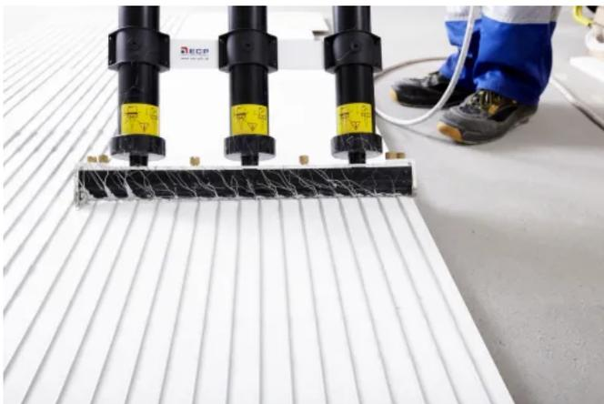
Maschineller Kleberauftrag (ca. 40 Sekunden pro m<sup>2</sup>)
