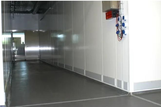
GFK-Dämmelemente mit H-Profil-Fuge
