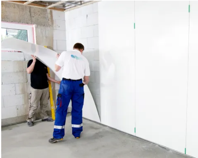
Der Kleber kommt direkt auf die Rückseite – die leichten Platten werden schnell und unkompliziert angebracht
