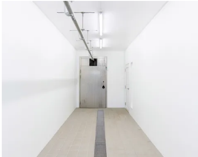
Wände und Decke mit Sanierungselementen von ECP
