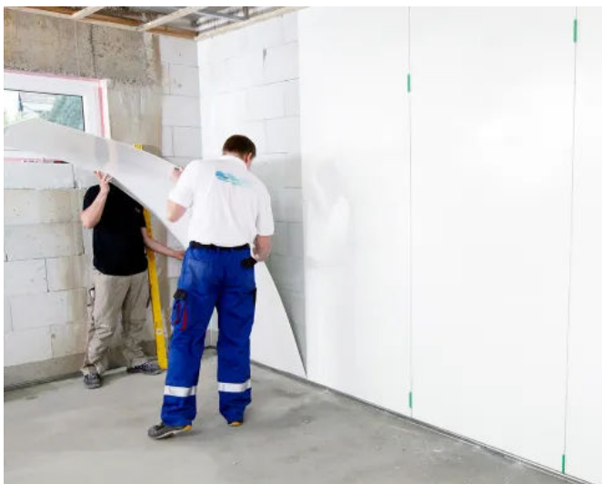
Der Kleber kommt direkt auf die Rückseite – die leichten Platten werden schnell und unkompliziert angebracht
