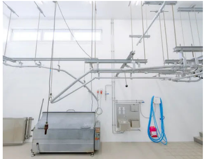
Wand und Decke mit Sanierungselementen und KL 25 Harter Fuge von ECP
