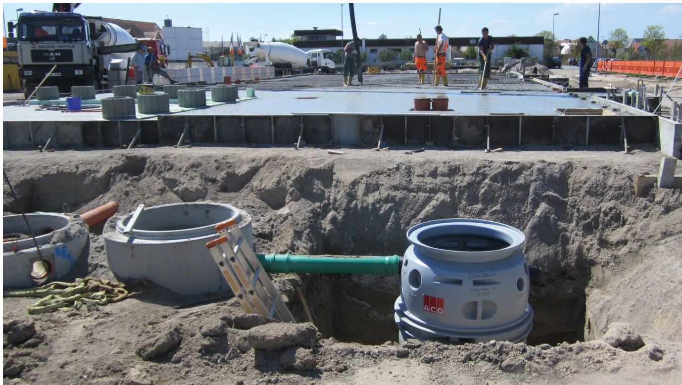
Fettabscheider aus Stahlbeton und PE-HD für den Erdeinbau
