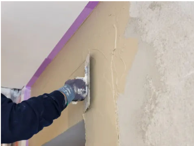
Von der Untergrundvorbereitung zur fertig verputzten Wand an einem Tag: Knauf Universal-Feinspachtel Sprint (© Knauf Presse)
