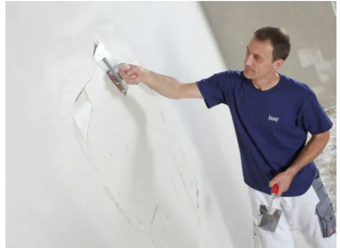
Hochwertige Putzflächen, fertig an einem Tag: Knauf Rotband Sprint - Gipsputz mit Sprinteigenschaften
