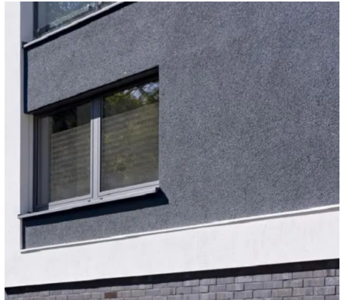
Fassadentechnik mit Siliciumcarbid
