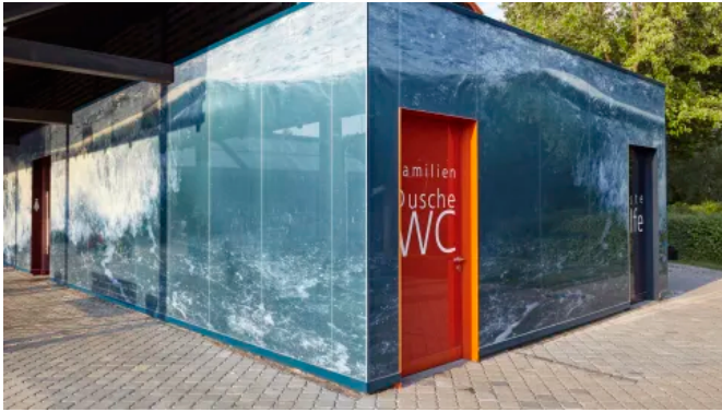
Farbig emailierte Fassadenplatten aus Einscheiben-Sicherheitsglas (© Bodo Mertoglu)
