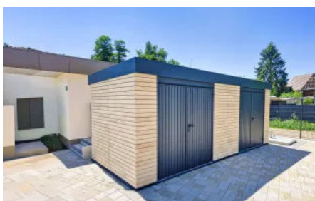
Flachdach-Gerätehaus M.1 mit Holzverkleidung
