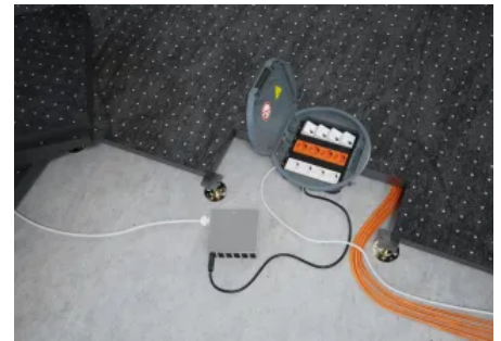
Consolidation Points für die flexible Strom- und Datenverteilung
