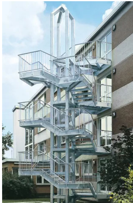
Objekt „Krankenhaus Berlin“
