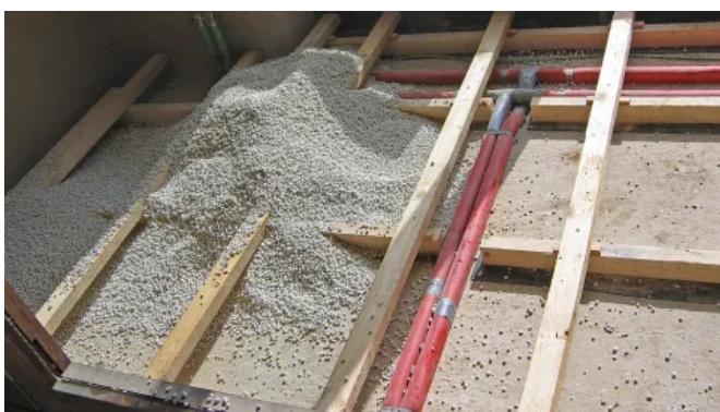
Anwendungsbeispiel: Ausgleichsschüttung zwischen Polsterhölzern
