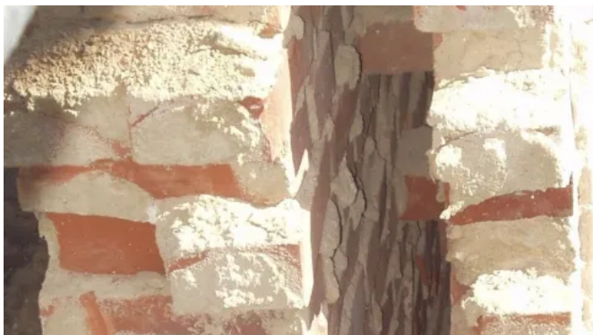
Zu dämmender Hohlraum zwischen Vormauerwerk und Hintermauerwerk
