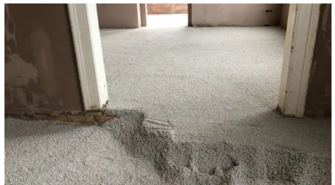
Anwendungsbeispiel: Gewölbedämmung mit GEOMATERIALS Blähglas
