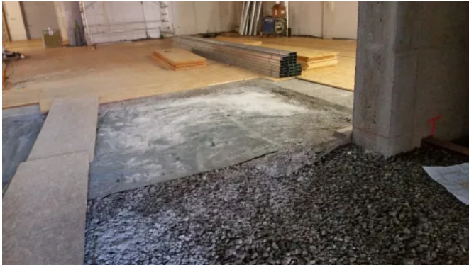
Anwendungsbeispiel: Fußbodensanierung - Kombination GEOMATERIALS Schaumglas & Blähglas
