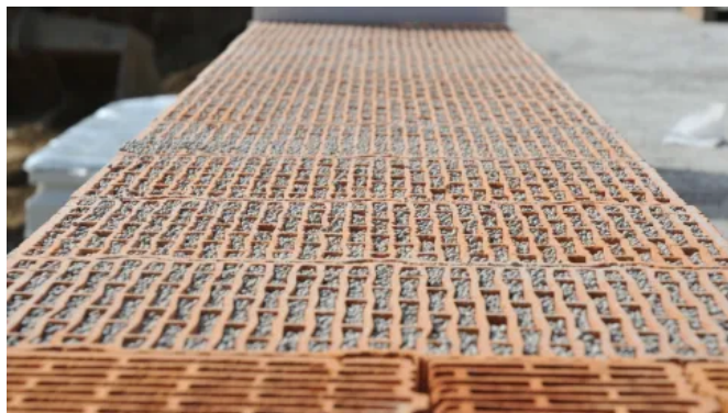
Das Granulat wird in die Hohlkammern des Ziegels eingefüllt
