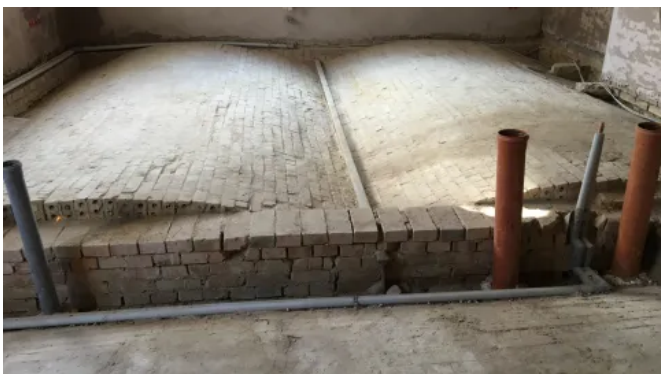
Anwendungsbeispiel: Gewölbedämmung mit GEOMATERIALS Blähglas
