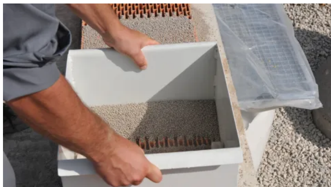
Das Verfüllen erfolgt mittels Granulatschlitten, der über die Ziegeln geschoben wird
