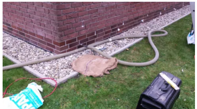
Einblasen von GEOMATERIALS Blähglas als Kerndämmung
