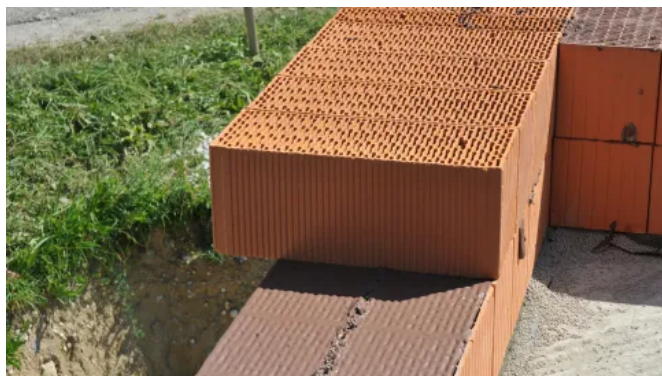
Der Deckenmörtel kann nach Freifegen der Ziegel wie gewohnt aufgetragen werden
