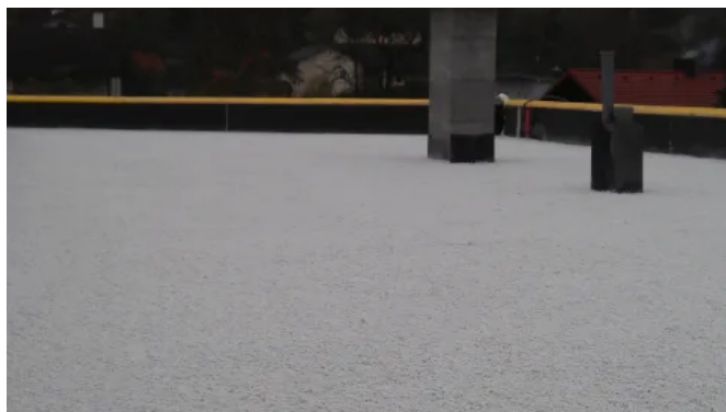
Unproblematisches Einbinden von Dachdurchdringungen
