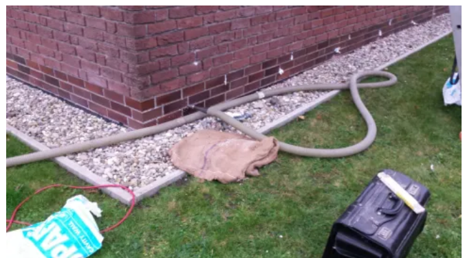
Einblasen von GEOMATERIALS Blähglas als Kerndämmung
