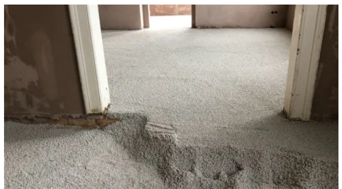
Anwendungsbeispiel: Gewölbedämmung mit GEOMATERIALS Blähglas
