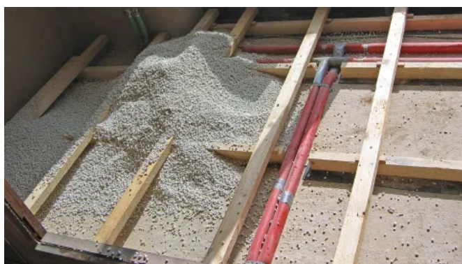
Anwendungsbeispiel: Ausgleichsschüttung zwischen Polsterhölzern
