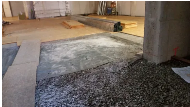
Anwendungsbeispiel: Fußbodensanierung - Kombination GEOMATERIALS Schaumglas & Blähglas
