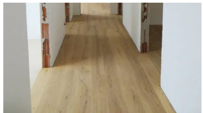
Anwendungsbeispiel: Parkett auf Holzbalkendecke mit Dämmschüttung
