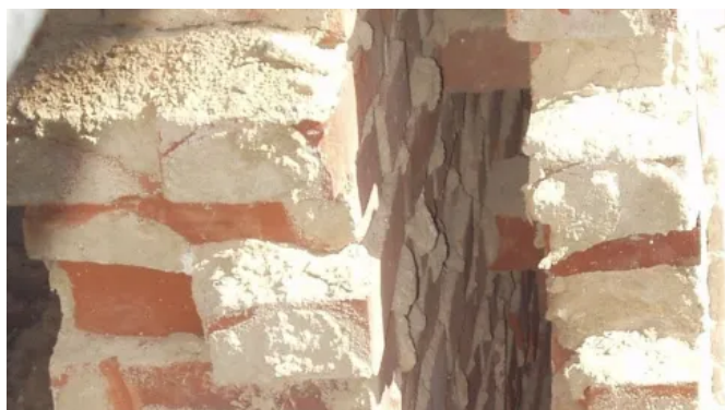
Zu dämmender Hohlraum zwischen Vormauerwerk und Hintermauerwerk
