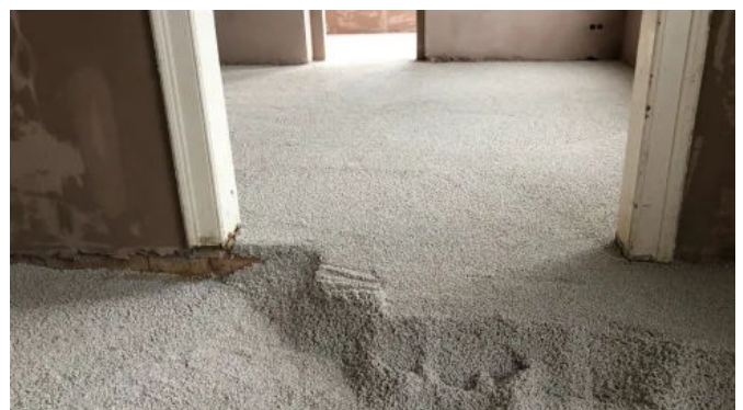
Anwendungsbeispiel: Gewölbedämmung mit GEOMATERIALS Blähglas
