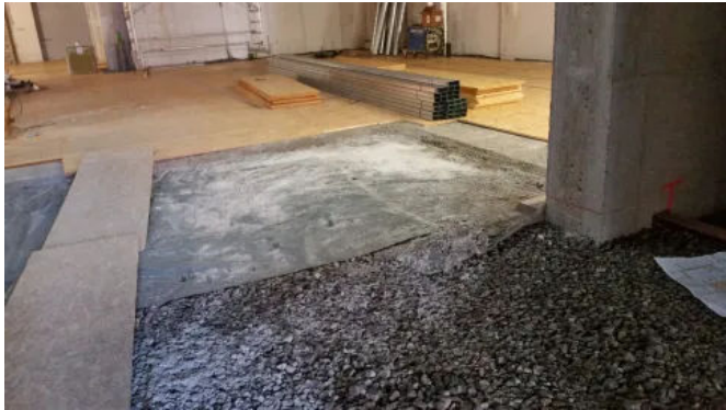
Anwendungsbeispiel: Fußbodensanierung - Kombination GEOMATERIALS Schaumglas & Blähglas
