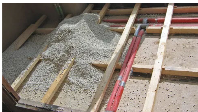
Anwendungsbeispiel: Ausgleichsschüttung zwischen Polsterhölzer
