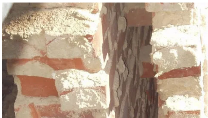
Zu dämmender Hohlraum zwischen Vormauerwerk und Hintermauerwerk
