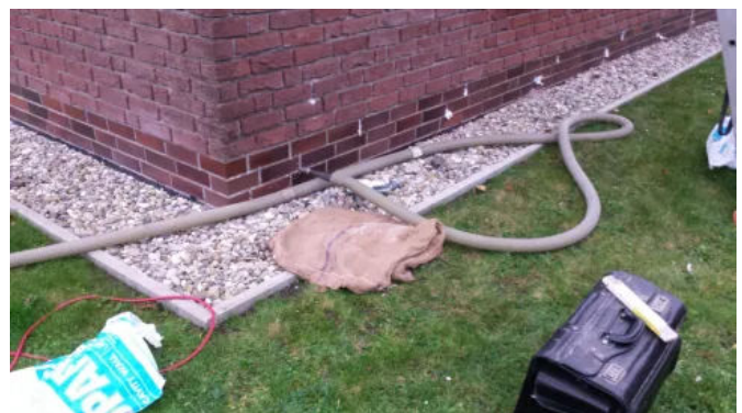
Einblasen von GEOMATERIALS Blähglas als Kerndämmung
