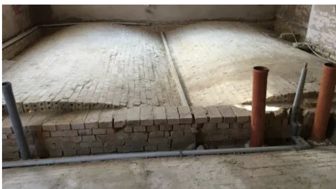
Anwendungsbeispiel: Gewölbedämmung mit GEOMATERIALS Blähglas
