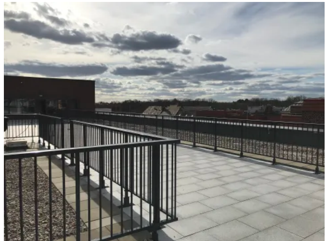
Geländer, die sich selber tragen: Panorama selbsttragend. Referenz VLB e.V. (© dani alu GmbH 2024)
