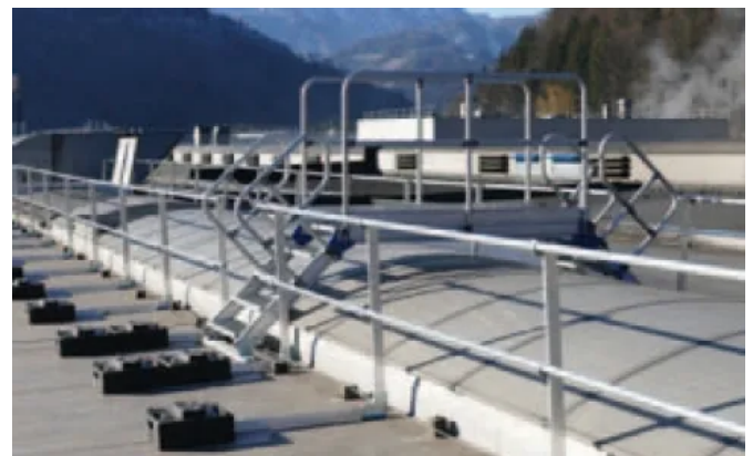
Barrial® Lichtbandsicherung mit Überstieg für sichere Dachzugänge
