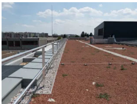
Barrial® selbsttragend TTV auf dem Gründach installiert
