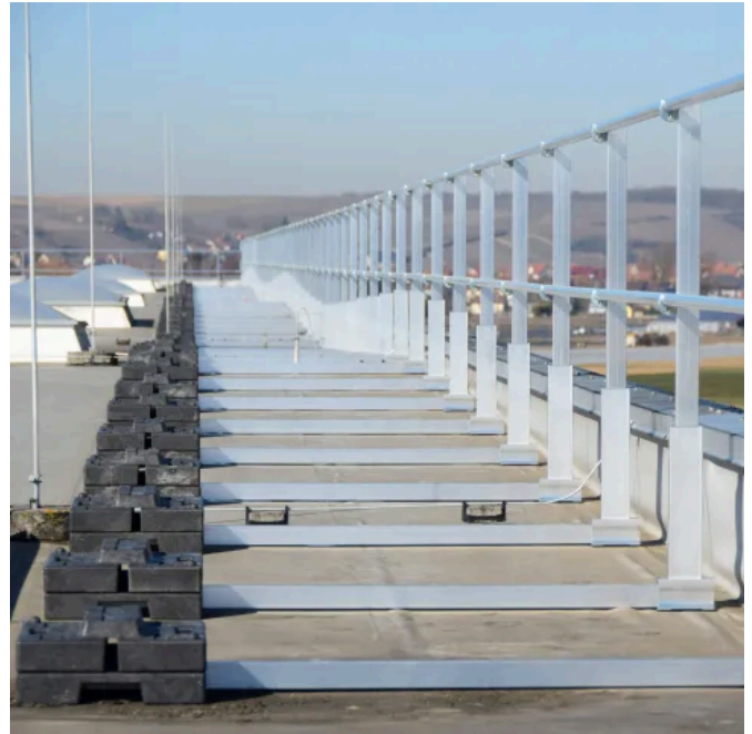
Barrial® selbsttragend für Wartungswege und Dachrand-Sicherung ohne Dachdurchdringung
