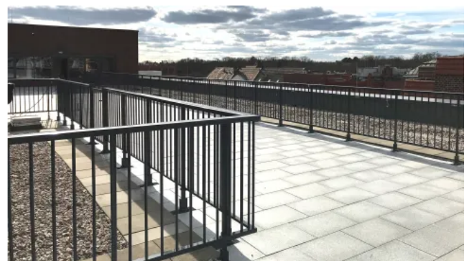
Panorama® C-ST mit vollflächiger Stabfüllung für sichere Flachdächer (© dani alu GmbH)
