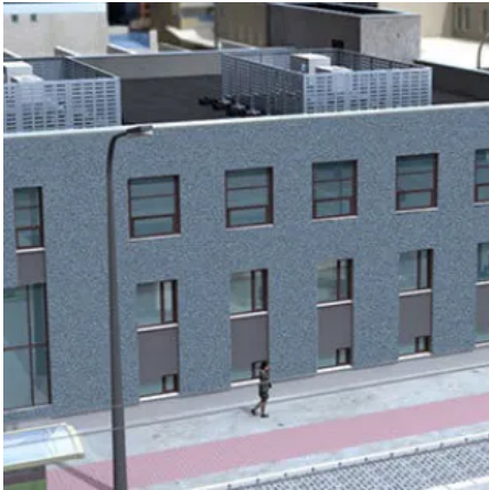
Paravent Sichtschutz – optische Einhausung technischer Anlagen auf dem Flachdach
