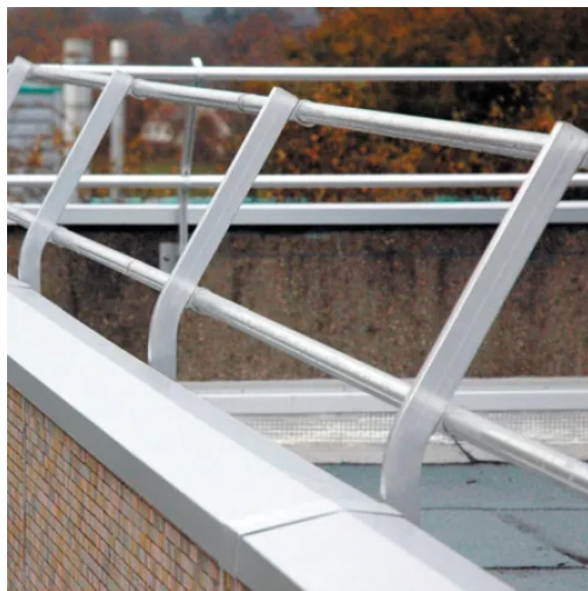
Barrial® fix auf der Attika-Oberseite montiert
