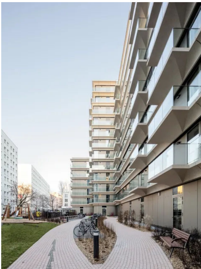
Balkone mit VISIOPLAN Ganzglasgeländer
