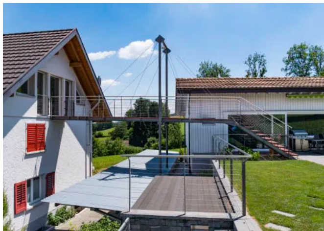
Geländerseile 3. Kuhgasse (© Achim Krug)
