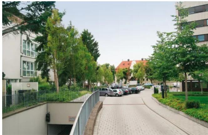
Fahrbeläge auf Dachflächen erfordern nicht nur einen tragfähigen Systemaufbau. Auch Kriterien wie die Tragfähigkeit der Dachkonstruktion oder horizontale Lasten, die durch Bremsen, Lenken und Beschleunigen entstehen, müssen berücksichtigt werden. Die Wahl der richtigen Steindicke und Verlegeart stellt sicher, dass die Pflasterung in ihrer Form erhalten bleibt.
