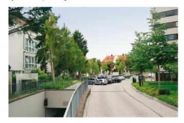
Fahrbeläge auf Dachflächen erfordern nicht nur einen tragfähigen Systemaufbau. Auch Kriterien wie die Tragfähigkeit der Dachkonstruktion oder horizontale Lasten, die durch Bremsen, Lenken und Beschleunigen entstehen, müssen berücksichtigt werden. Die Wahl der richtigen Steindicke und Verlegeart stellt sicher, dass die Pflasterung in ihrer Form erhalten bleibt.
