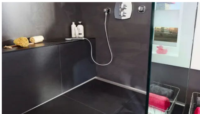
BLANKE AQUA-DEKO verbaut
