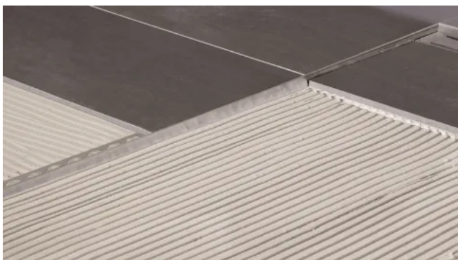
BLANKE AQUA-KEIL verbaut
