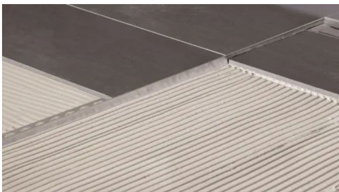
BLANKE AQUA-KEIL verbaut
