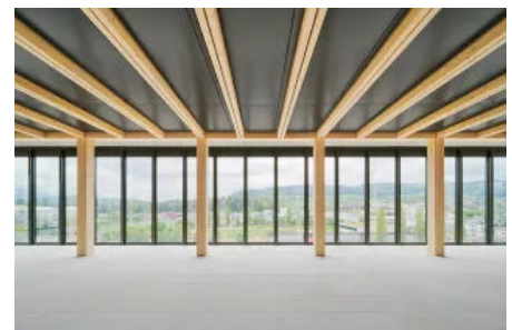
Die Fensterflächen bleiben frei, die Holzoberflächen bleiben sichtbar.
