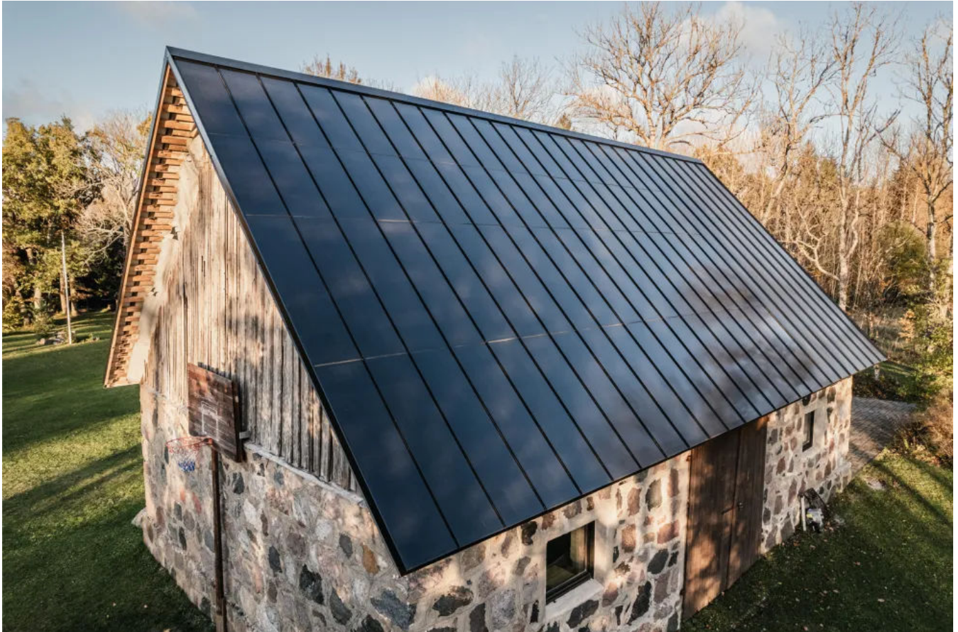
Land: Estland, Ort: Niitvälja Farm, Objekt: LandwirtschaftlicheR Betrieb, Installation: 2020; Leistung: 9,72 kWp
