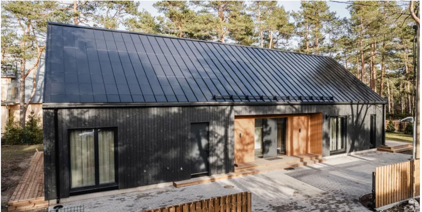
Land: Estland, Ort: Nõmme, Objekt: Wohnhaus. Installation: 2023; Leistung: 7,64 kWp
