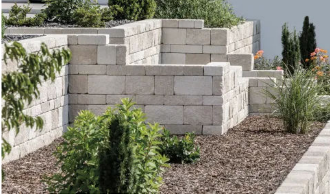
GDM.MOLINA wall, proActive Set 20 und Set 10, antikplus, Kalkstein hell, mittel und dunkel, proClean 100, Wechselmauerwerk
