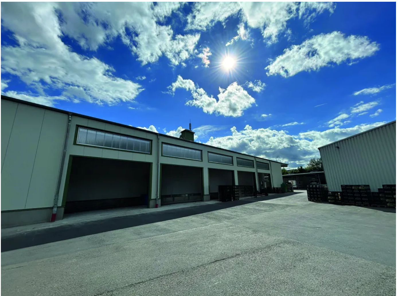
Aurora Set basic plus – eingesetzt in einer Industriehalle
